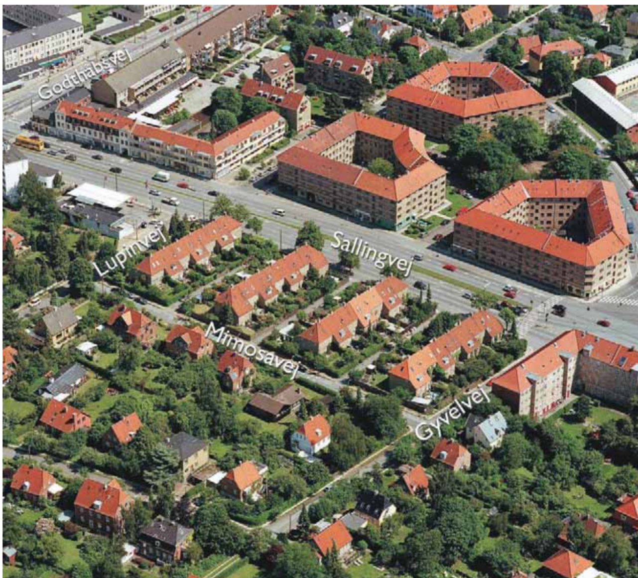
Luftfoto af området set mod øst (JW Luftfoto juni 2005). Rækkehusbebyggelsen er mod Sallingvej omgivet af etagebebyggelse og mod Mimosavej af villabebyggelse.
